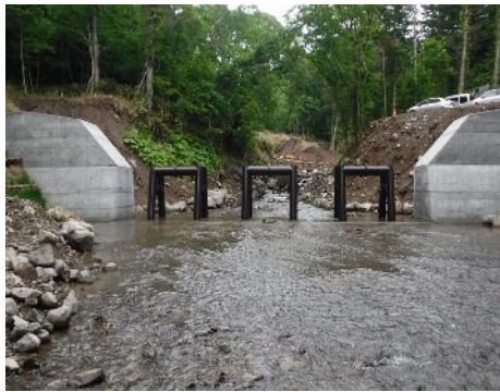
流木捕捉式治山ダム工 (令和4年3月 北海道伊達市)
