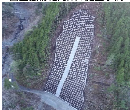
山腹工 (令和4年3月 高知県馬路村)
