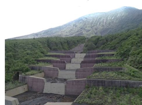
溪間工 (鹿児島県桜島地区 九州森林管理局)
